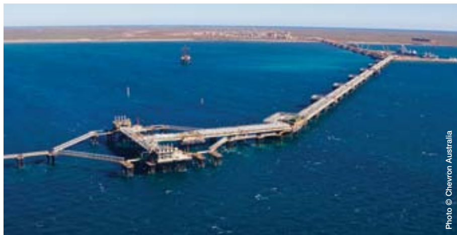
The LNG jetty for the Gorgon Project nears completion
